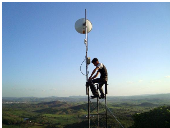
Instalação de antena de internet no CEBB Darmata.
