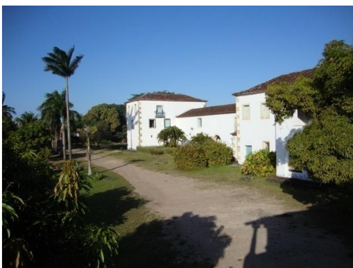
Anexo onde funcionava o convento.
